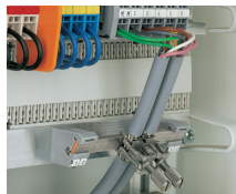
Szigetelt rögzítő adapterek a közös árnyékolási referencia potenciálhoz, függetlenül a készülékház potenciáljától
